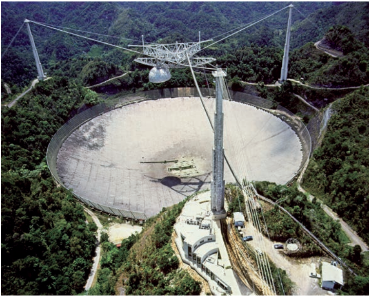
Fig. 4.24. Radiotelescopio del observatorio de Arecibo, Puerto Rico. Su diámetro es muy grande para disminuir el efecto de la difracción.
