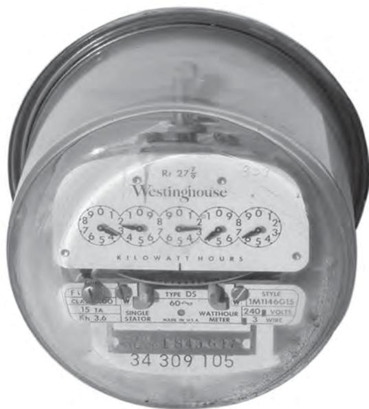
**Fig. 2.41.** Medidor de consumo eléctrico electromecánico.
