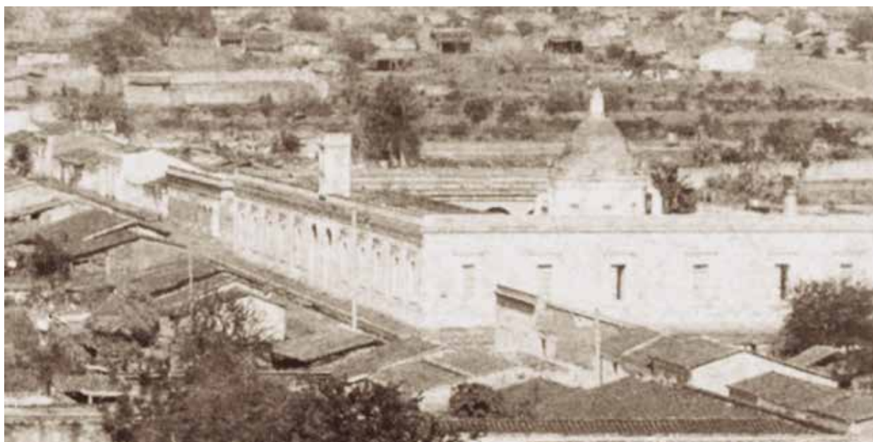
Imagen 24. Hospital del Carmen en Culiacán
